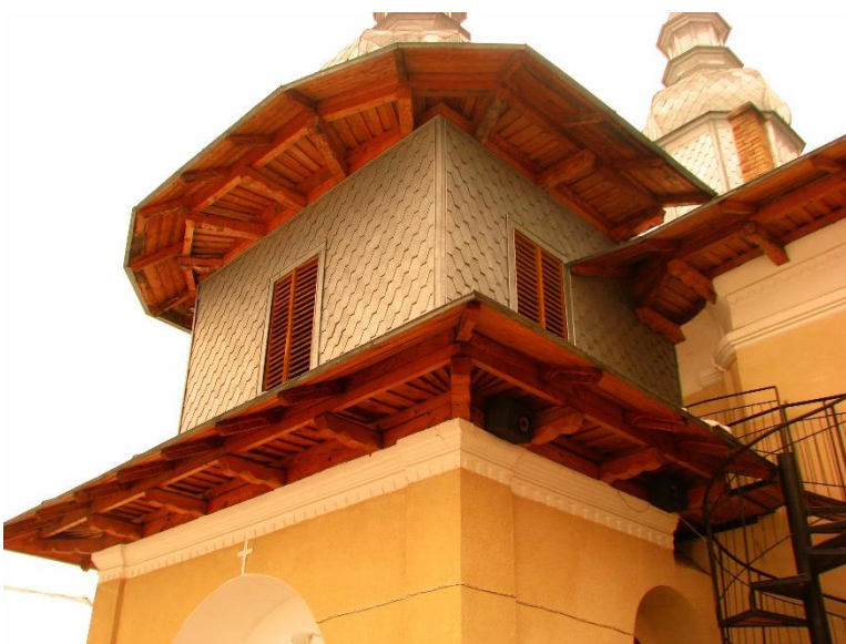
Detaliu Turn-Clopotnita- Fatada Sud- Est
