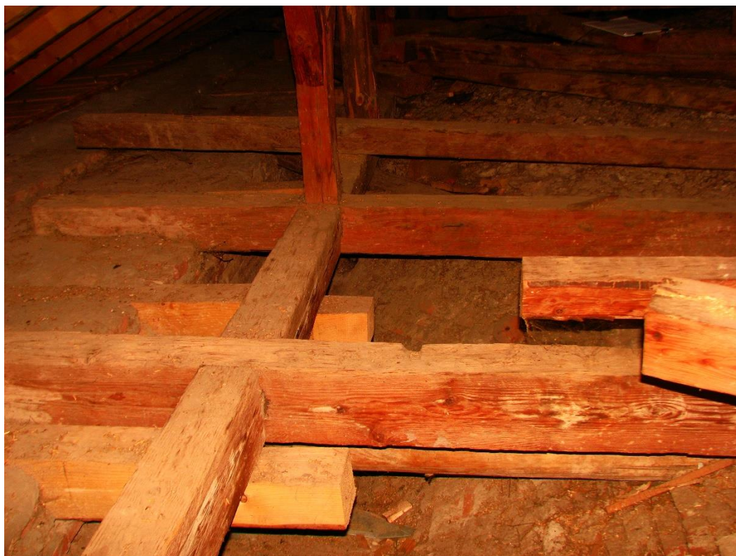
Detaliu sarpanta pod- zona streasina
