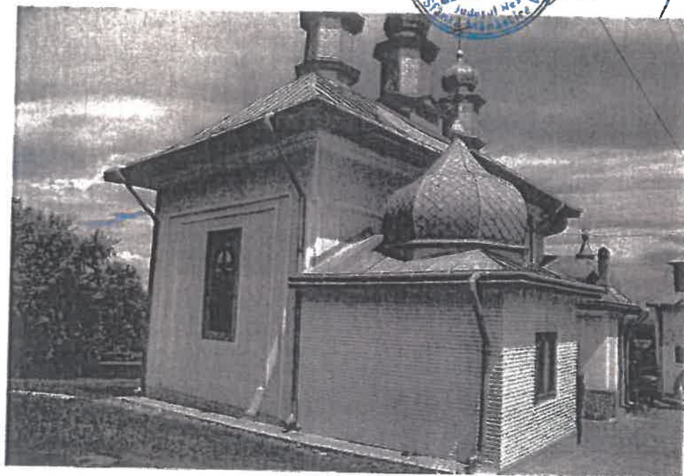
Foto 12.3 Vedere fațadă vest
